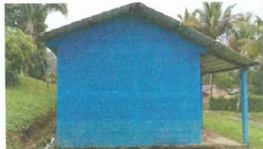
Foto 2: VISTA DE LA PARTE LATERAL DERECHO DEL CENTRO EDUCATIVO PARA REMOZAR REPELLO Y SIMIENTO DE PISO.
